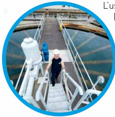
L'usine de traitement historique du Val a une capacité de traitement de **1660 m<sup>3</sup>/h** (40 000 m<sup>3</sup>/jour). Elle traite l'eau provenant des **forages du Val** (Le Theuriet, le Bouchet et le Gouffre) et, plus récemment, des **forages de l'Oiselière**. Elle dispose d'une capacité de **stockage de 50 000 m<sup>3</sup>**.
